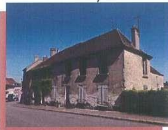
Maison de bourg : R+1, toiture à croupe aveugle. Organisation de la façade sur rue en travées. Façade aveugle sur la cour des Logis. Importante maison construite en deux phases. Élément faisant la jonction avec la cour des Logis.
